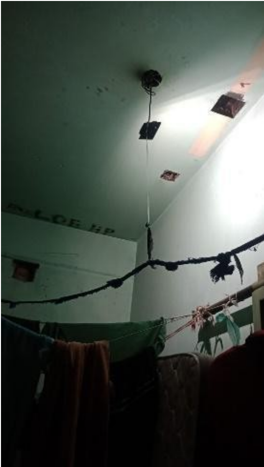
Comisaría 1. Imagen del único artefacto de luz y de la instalación eléctrica precaria
