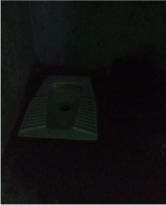
Comisaría 1: Imagen del baño deteriorado sin luz natural ni artificial
