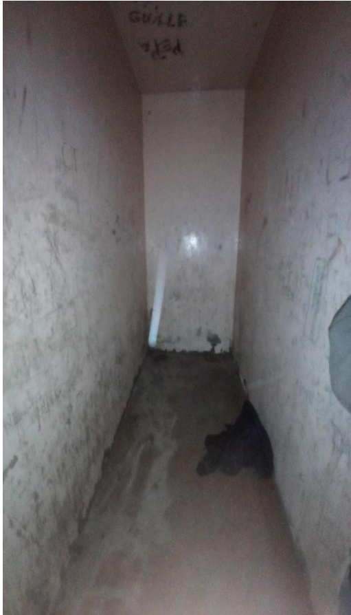
Comisaría 2. Celda 1 de contraventores sin ventana.
