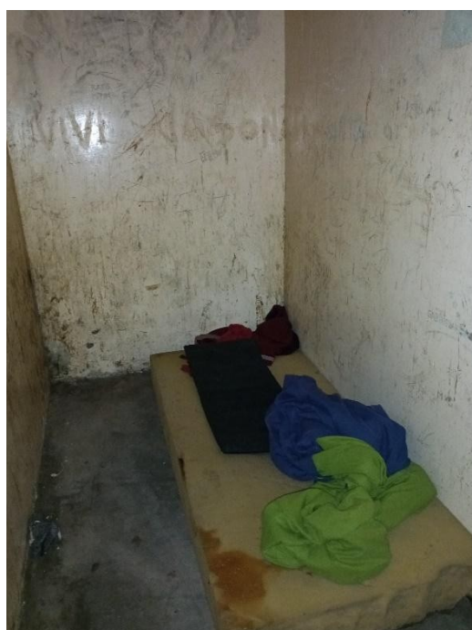
Comisaría 2. Celda 3 de contraventores sin ventana.
